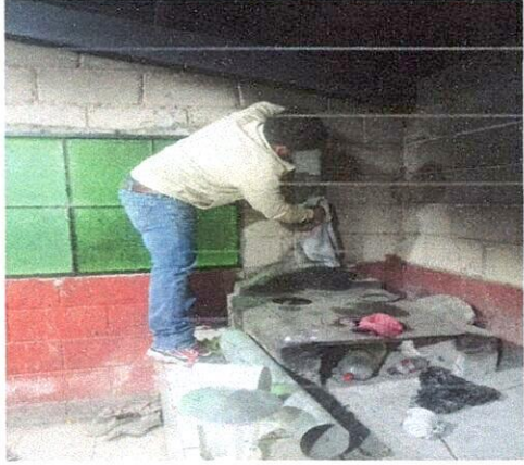
Foto1: Cambio de chimenea de la cocina.
