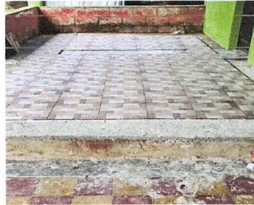
Foto 4: Colocación de piso antideslizante en el corredor de la cocina.
