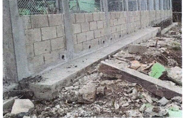
Foto 2: Construcción de una banqueta en el exterior del centro educativo.
