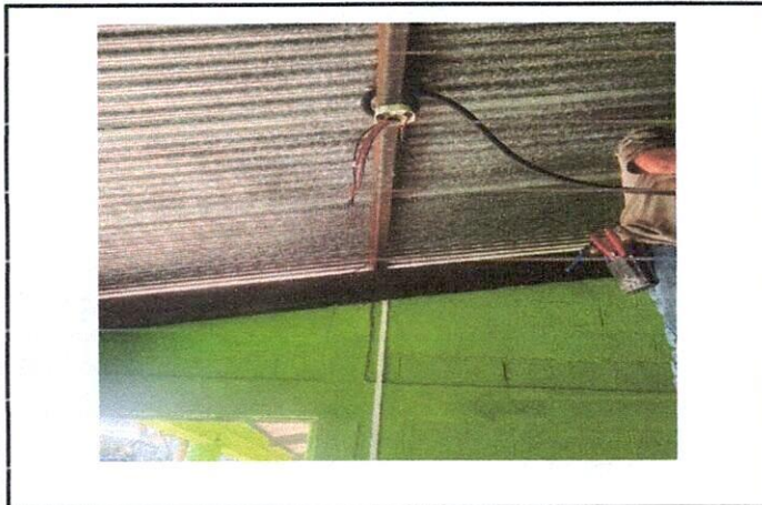
Foto 3: Reparación de instalación eléctrica.
